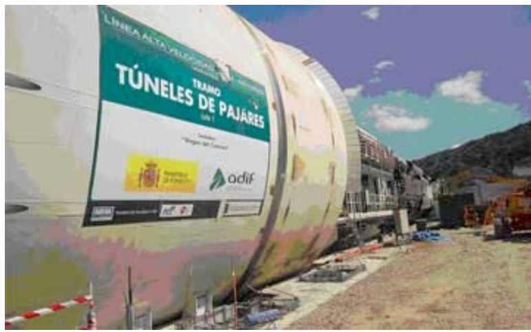
Vista de la Tuneladora Virgen del Camino
